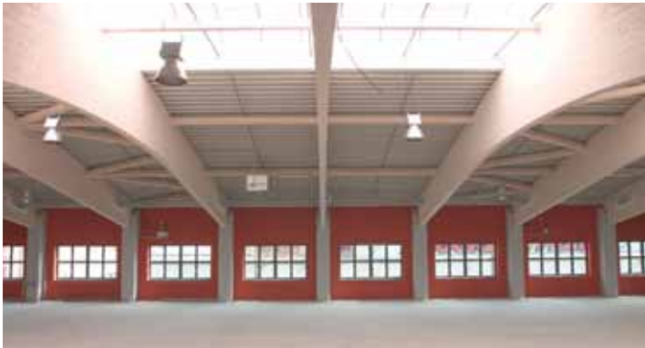
Izolacija tavanice, dvorana Fulda
