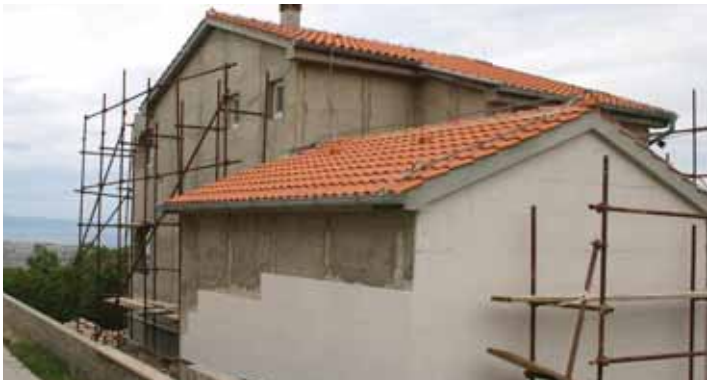
Izolacija porodične kuće sa spoljne strane zida
