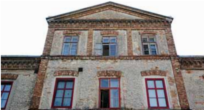
Izolacija unutrašnjih zidova objekta iz 19. veka, Austrija
